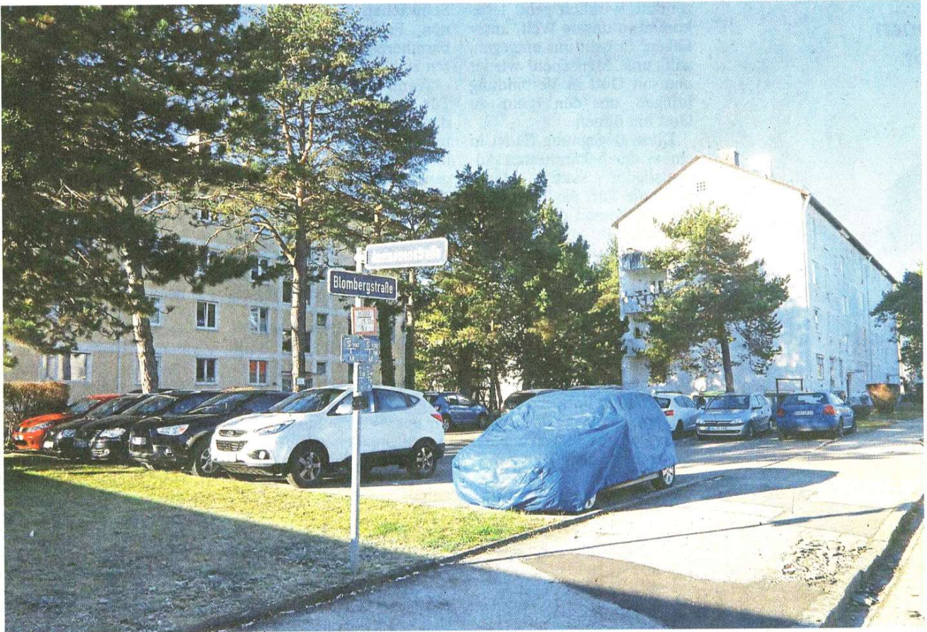
65 statt 40 Wohnungen: Diese Gebäude an der Blombergstraße sollen abgerissen werden.
