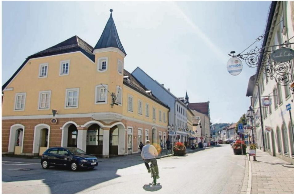
Noch hat der Stadtrat die Kurve nicht gekriegt: Wie mit der maroden städtischen Immobilie am Untermarkt 10 (li.) verfahren wird, steht auch vier Jahre nach Beginn der Debatte nicht fest.
