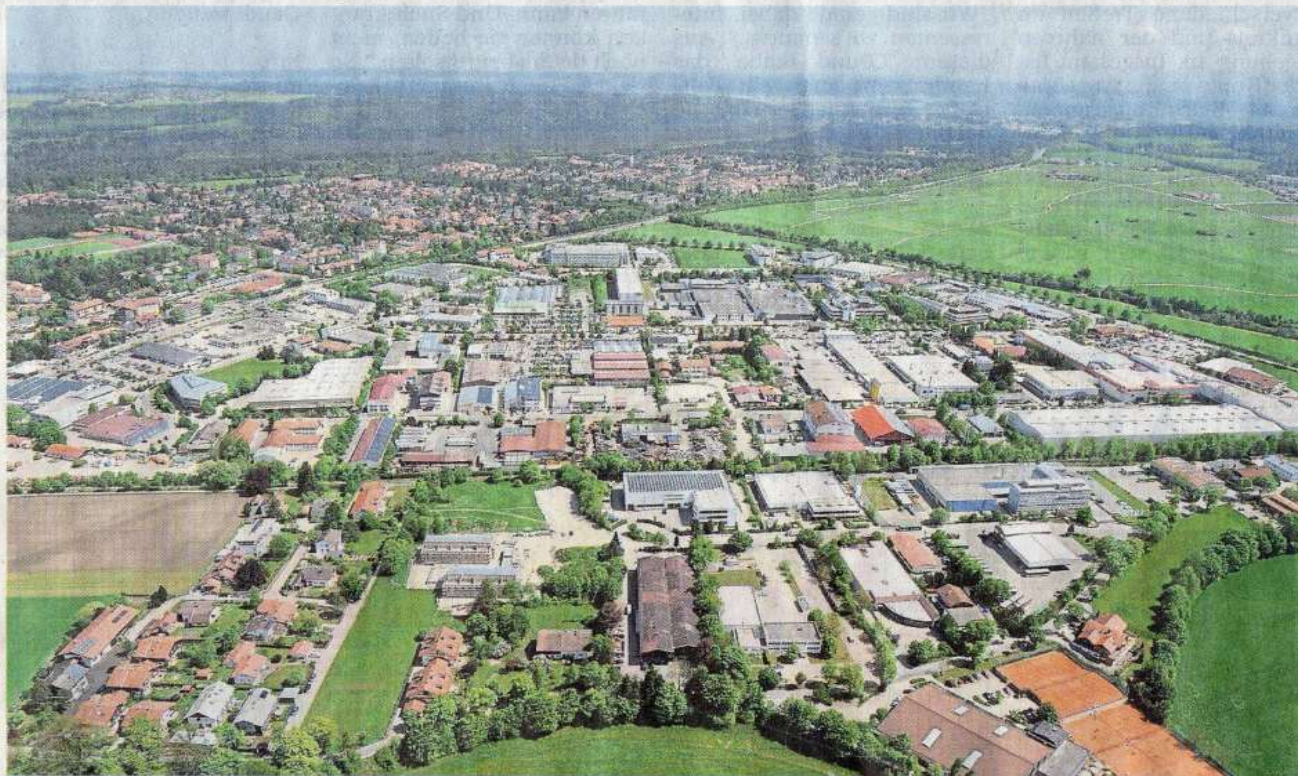
Wirtschaftsstandort Wolfratshausen: 2045 Unternehmen bieten insgesamt 8528 Arbeitsplätze.
