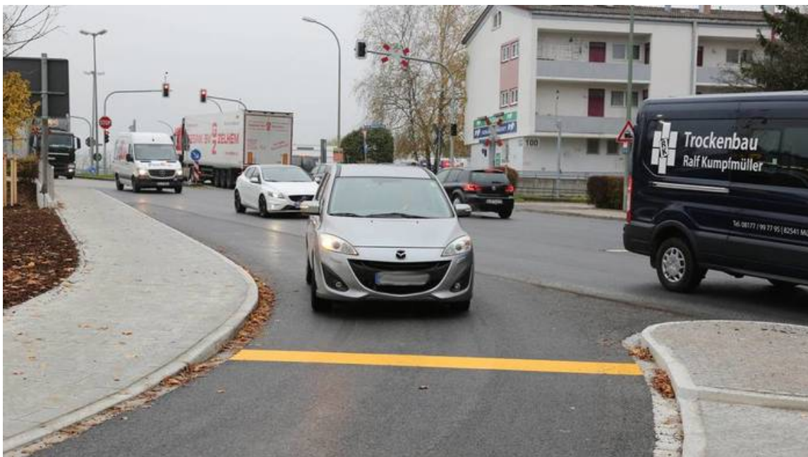
Die Fahrbahnmarkierungen fehlen noch auf der neu gestalteten Roma-Kreuzung. Foto: HERMSDORF-HISS
